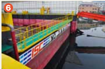
↑潮の干潮を待ってドックと海とを仕切るゲートを大型クレーンで取り付けるのだが、この日の干潮時間は午前6時。前日は午前5時がその時間
